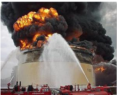
شکل ۲-۷ آتش استخری مواد قابل اشتعال در مخزن ذخیره (راست) و آتش استخری ناشی از ریختن سوخت هواپیما (چپ).
