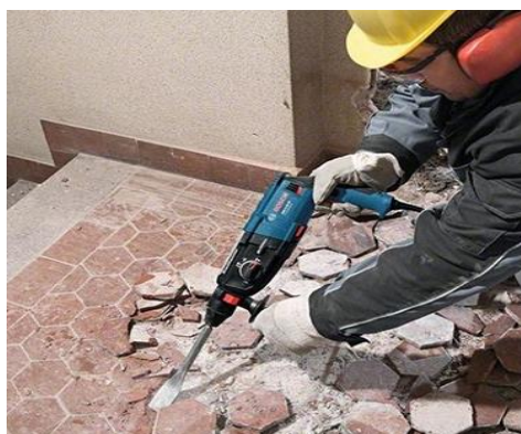
شکل ۲۰-۱ دستگاه پیکور یا چکش تخریب (راست) و دستگاه سنگ فرز (چپ)(تصویر: نویسنده).
