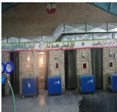
شکل ۴-۶ کابین‌های فیوم جوشکاری (راست) (تصویر از نویسنده) و تهویه موضعی جوشکاری (چپ).
